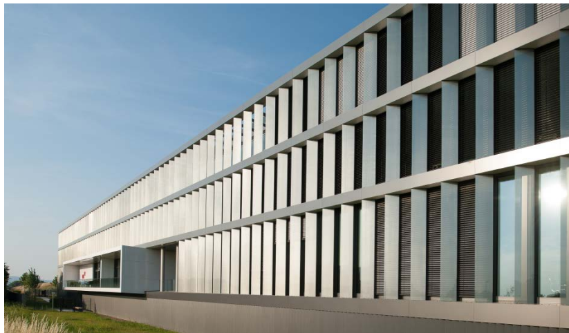
DAL, Dienstleistungszentrum Oberstadt
