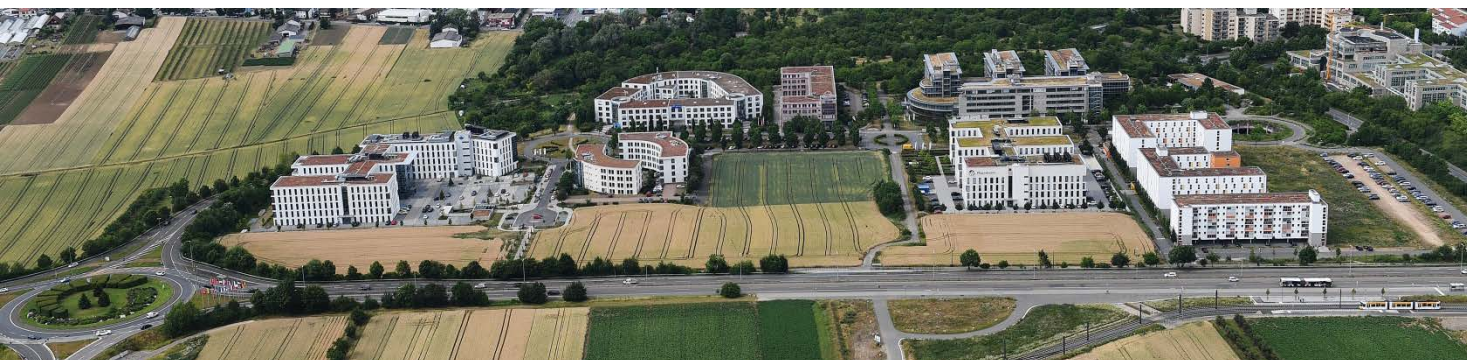
Tertiärstandort Kesselberg (Blick von Süden)
