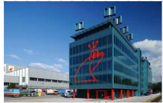
Bekennnis zu Mainz: das neue Verwaltungsgebäude von Werner & Mertz.
